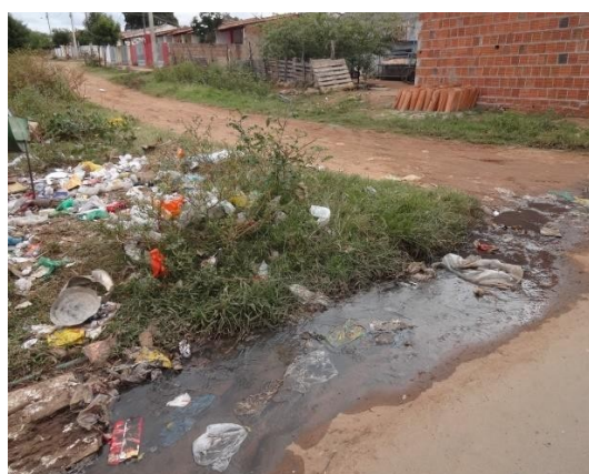
Figura 22 - Esgoto misturado com o lixo no bairro Brejo Seco
