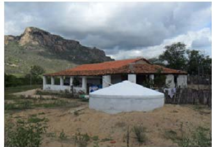
Figura 39: cisterna de placas
