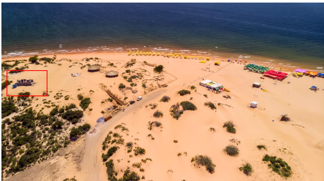
Figura 16 – Vista de edificações irregulares
