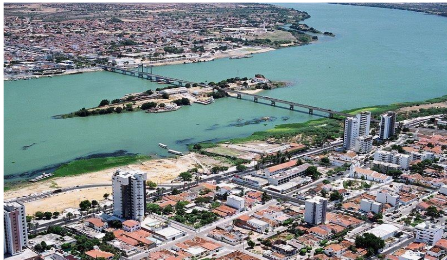
Figura 6 – Fotografía aérea parcial de las ciudades de Juazeiro/BA y Petrolina/PE
