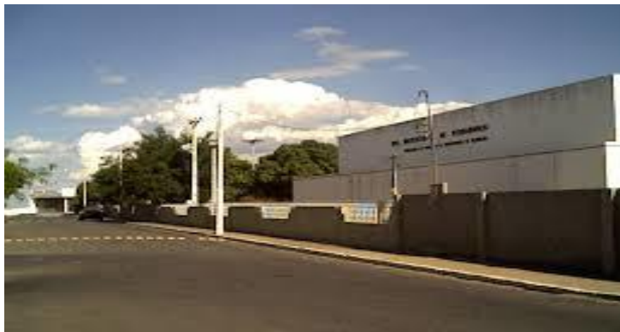
Figura -06 – Edificio donde funciona la EEAVSF – Petrolina/PE/Brasil
