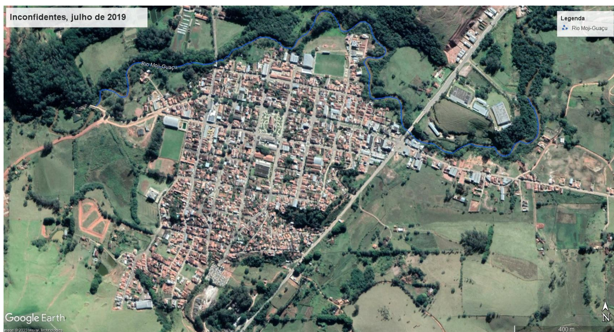
Figura 7 - Ruas do espaço urbano de Inconfidentes, no ano de 2019, antes do início das obras de pavimentação asfáltica.
