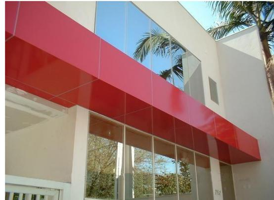
Figura 82: Revestimento em ACM vermelho
