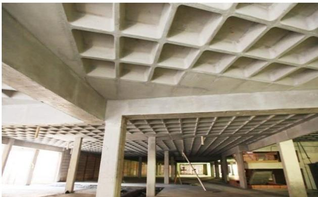
Figura 79: Laje Nervurada e pilar em concreto armado
