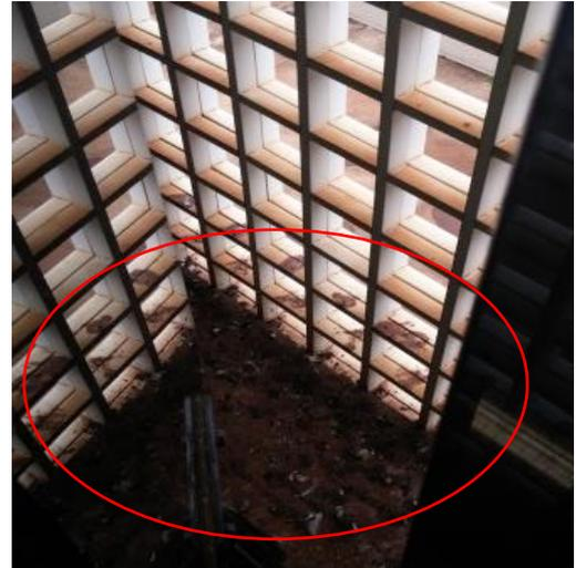
**Figura 23 e 24:** Malha de alumínio vazado / presença de pombos e sujeiras deixadas por eles.
