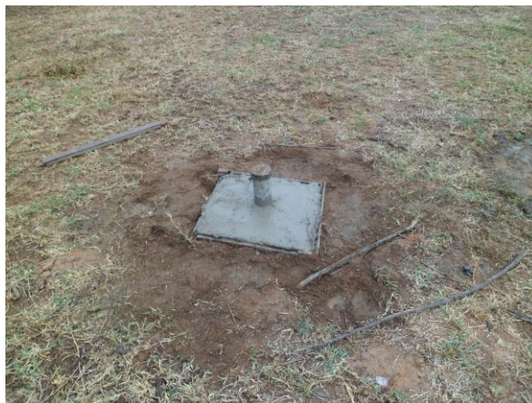
Figura 10. Proteção de concreto e tubo de acesso com tampa de ferro.
