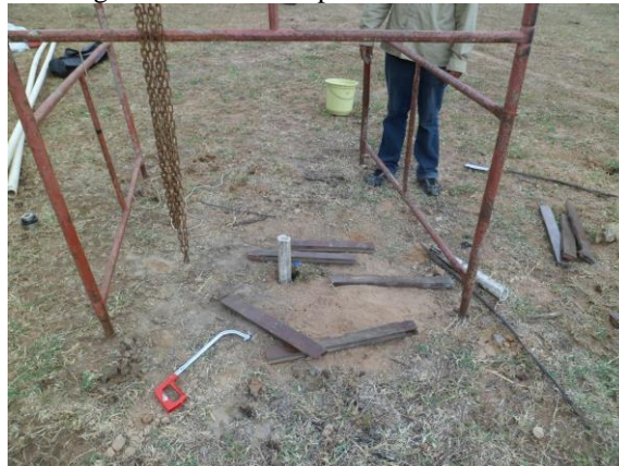
Figura 9. Detalhe do piezômetro instalado.
