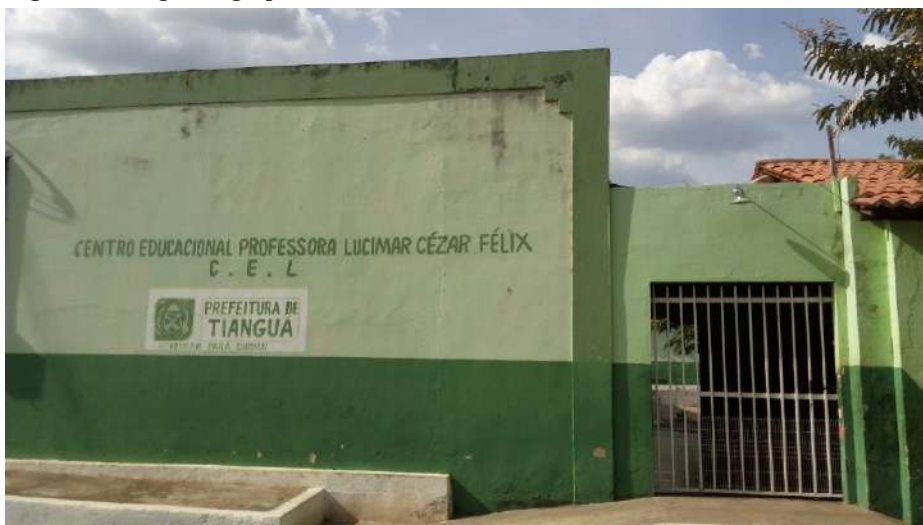
Figura 02: Segundo grupo escolar do Distrito construído em 1966 em sua forma atual.
