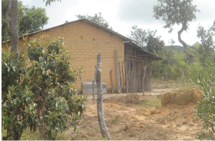
Figura 4: Casa Construída em Tijolo com Parte em Taipa (pau a pique)
