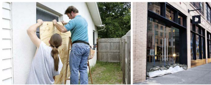
Figura 3 - Antes da chegada de um furacão é comum proteger as janelas e vedar as portas, assim como guardar barcos, material de salvamento das praias, etc, armazenar comida, água e medicamentos, e organizar a distribuição, se necessário.
