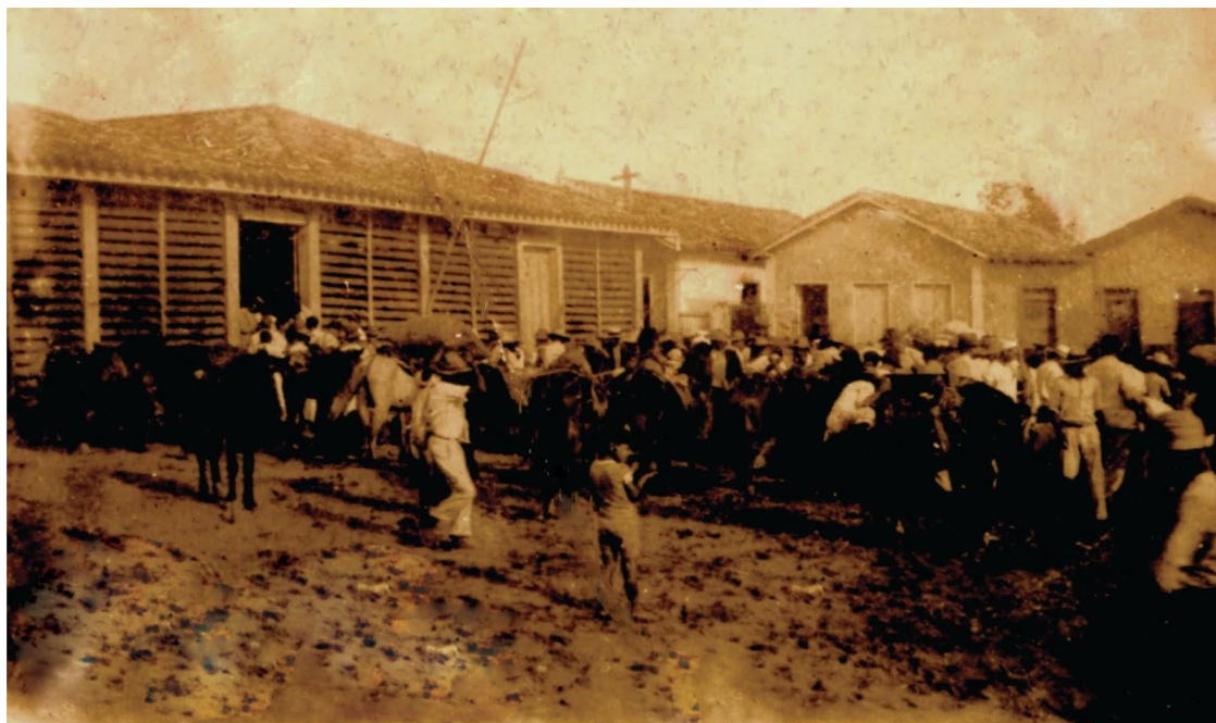
Figura 36 – Época em que o barracão era utilizado como entreposto comercial. Fonte: Soares (2015).
