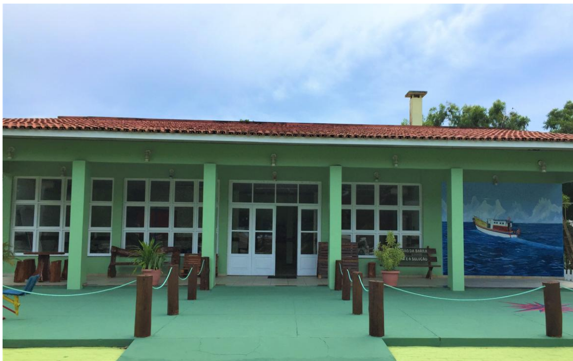
Figura 48 – Entrada principal do Espaço da Ciência.
