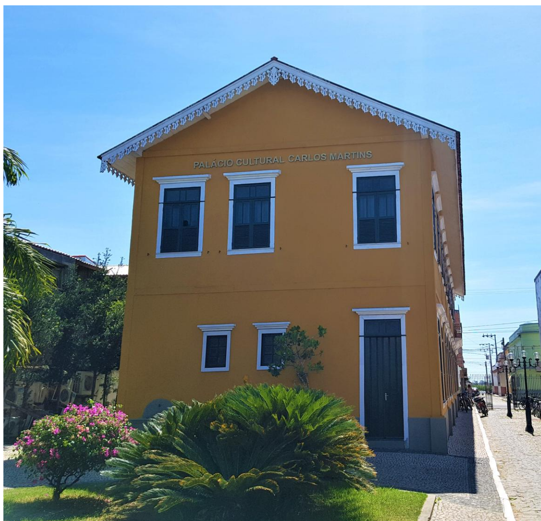
Figura 39 – Fachada do Centro Cultural Carlos Martins.
