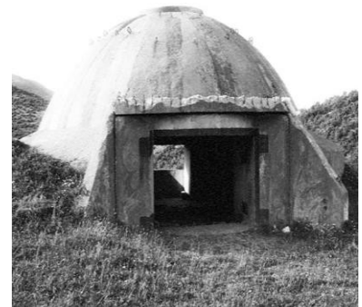
FIGURA 14 – “BUNKER ALBANIA DANIFICADO”, AUTOR, JIRKA DL.
