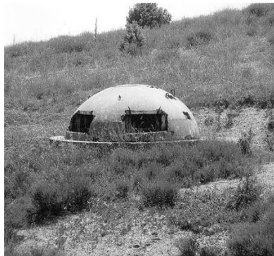
FIGURA 13 – “BUNKER ALBANIA DANIFICADO”, AUTOR, FINGALO
