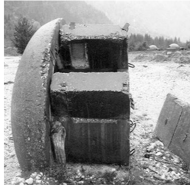
FIGURA 14 – “BUNKER ALBANIA DANIFICADO”, AUTOR, JIRKA DL.
